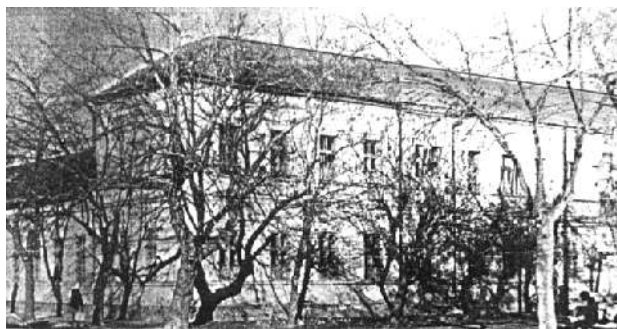
Az emelet-ráépítéssel bővült fiúiskola
